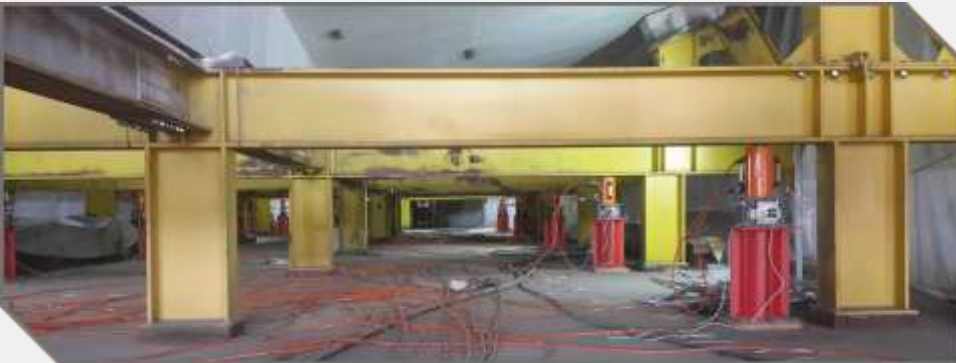
Ship Lifting Application / Gemi Kaldırma Uygulaması
